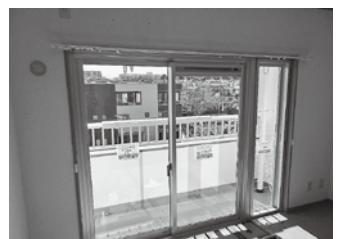
新しい窓ガラス取り付け後の様子
