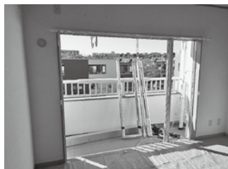
既存の窓を撤去した状態
