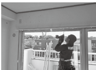
既存枠にかぶせるように新しい窓枠 の取り付け
