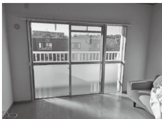
施工前の既存の窓
