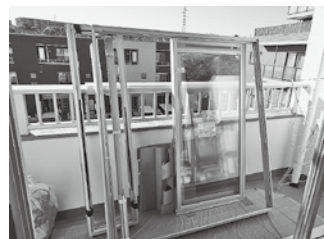
設置前の新しい窓枠
