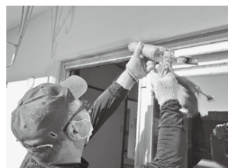
新しい枠の外回りに防水材を注入
