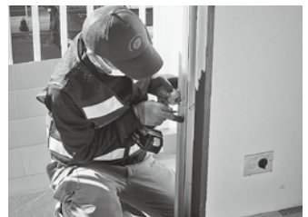
取り付け下地材のビス止め
