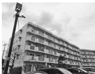
外部の出入り自由な団地型のため、各所に防犯カメラを設置している
