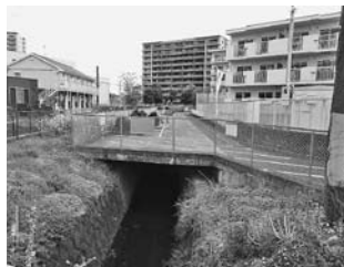
用水路の土砂の清掃込みで管理組合が借りている隣地の駐車場
