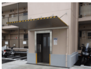
地上階の出入口。前後2方向出入口タイプを採用
