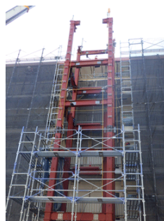
東芝エレベータ製 積載量：600kg 定員：9人 速度：45m/分 停床：6床（地上階+1～5階）
