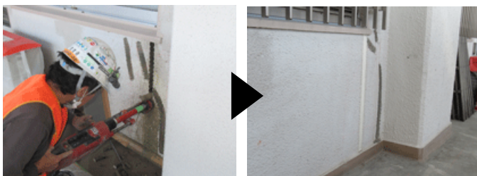
共用廊下住戸側壁に耐震スリット設置
