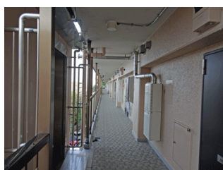
共用廊下側は、出入口前の住戸の給湯器を排気筒タイプに交換
