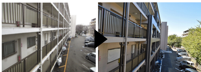
横から見る外付けフレーム（施工前、施工後）
