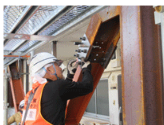
ブレース継手部本締め、継手部のボルト挿入状況
