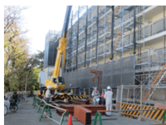
鉄骨材の組み立て状況
