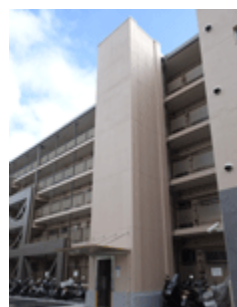
東芝エレベータ製 積載量：600kg 定員：9人 速度：45m/分 停床：6床（地上階+1～5階）
