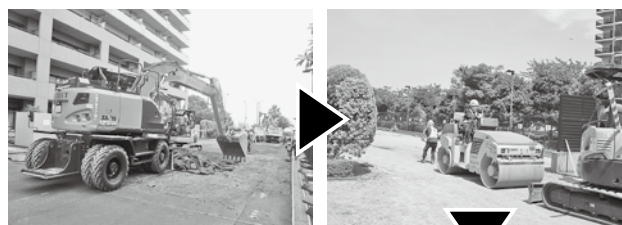
外構アスファルトの施工前と施工後
