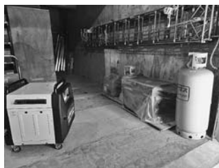
2013年、受水槽跡を防災倉庫に転用。現在はLPガス式発電機、チタン製三連はしごなどを装備している
