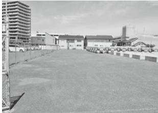
施工中の臨時駐車場は、横須賀市港湾管理課などから土地を借りて110台分を確保した
