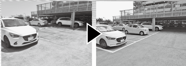
3階建ての自走式立体駐車場は防水止水性能に優れた浸透性コンクリート改質材を採用
